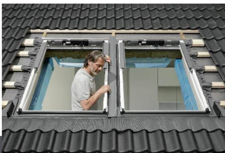
Die neue flexible Mittelrinne des Kombi-Eindeckrahmens erleichtert den Einbau von Velux Lichtlösungen deutlich. Bei der Montage wird sie zunächst am linken Fenster angesetzt und von oben in das Eindeckrahmen-Unterteil eingeschoben.
