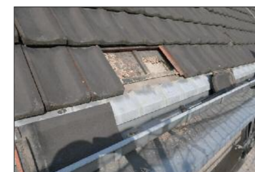
Bild oben: Nach dem Entfernen der alten Dämmung lag die Betonfläche rund 60mm hinter der Sparrenebene zurück. Bild unten: Dämmung mit Sauerkrautplatten und Rinne auf der Simsabdeckung
