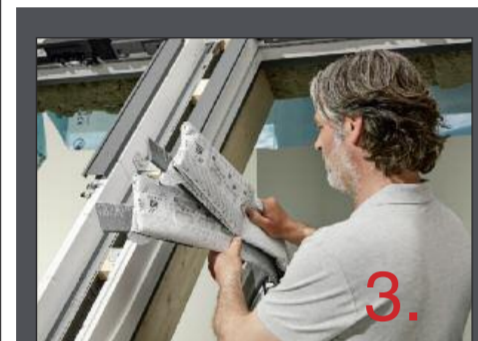
Auf den im Lieferumfang enthaltenen Anschlussschürzen ist jeweils vermerkt, ob sie auf der rechten und oder linken Seite zum Einsatz kommen.
