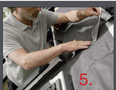
Mit dem im Lieferumfang enthaltenen Klebeband lassen sich die übereinandergelegten, glatten Schürzen ganz einfach und sicher abdichten.
