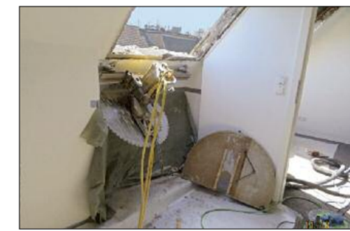
Für den Einbau größerer Fenster wurde der Beton ausgesägt.
