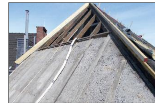
Bild oben: Nach dem Entfernen der alten Dämmung lag die Betonfläche rund 60mm hinter der Sparrenebene zurück. Bild unten: Dämmung mit Sauerkrautplatten und Rinne auf der Simsabdeckung
