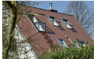
Prinzip Offenheit im Dach. Weil in der historischen Stahlfassade keine weiteren Öffnungen entstehen dürfen, planten die Architekten mit Dachfenstern für mehr Licht und Luft.
