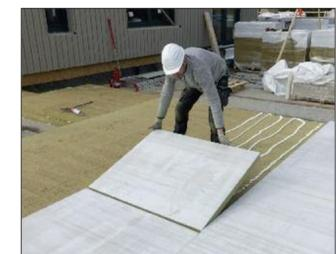
des Dämmsystems „Georock 038“. Laut Windlastberechnung konnte die dreilagige Dämmung durch Verklebung ausreichend lagegesichert werden. Zu einer belastbaren Nutzschiene wurden „Solarrock“ Dämmplatten in 60 mm Dicke verklebt. Ausgerüstet mit
