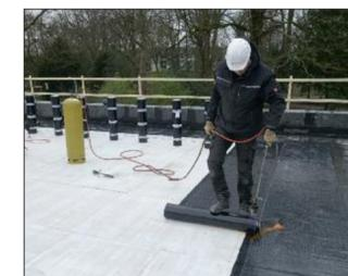
einer glasfaserverstärkten, hoch lastverteilenden Zementbeschichtung eignen sich diese ideal für höher belastete Flachdächer. Abschließend wurde eine wurzel- und rhizomfeste Elastomerbitumen-Schweißbahn aufgebracht.
