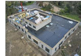
Rund 1.200 m<sup>2</sup> Dachfläche wurden auf diesem Kita-Neubau in Hilden mit nichtbrennbaren Systemen von ROCKWOOL gedämmt.
