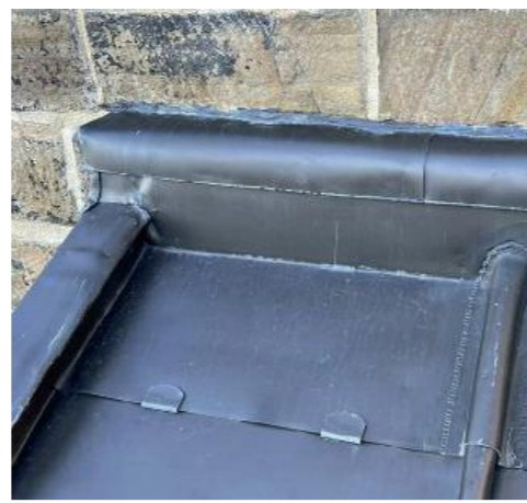
Sorgfältig ausgeführte Lötverbindungen sorgen an Anschlüssen und Aufkantung für eine dauerhaft dichte und stabile Bleindeckung – ideal für anspruchsvolle Detailpunkte am Bau.
