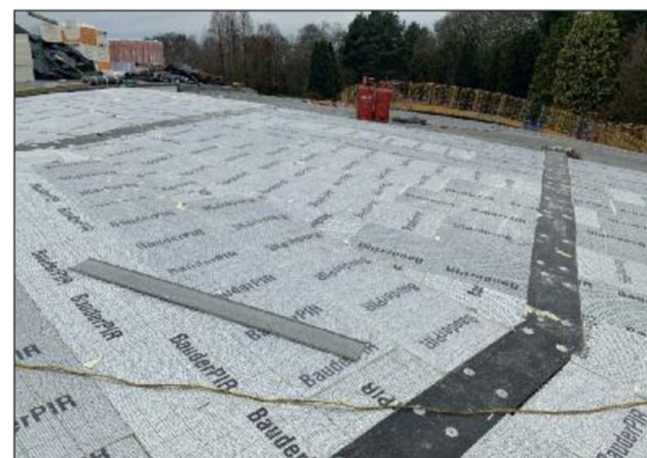
Verlegte Wärmedämmung aus BauderPIR.
