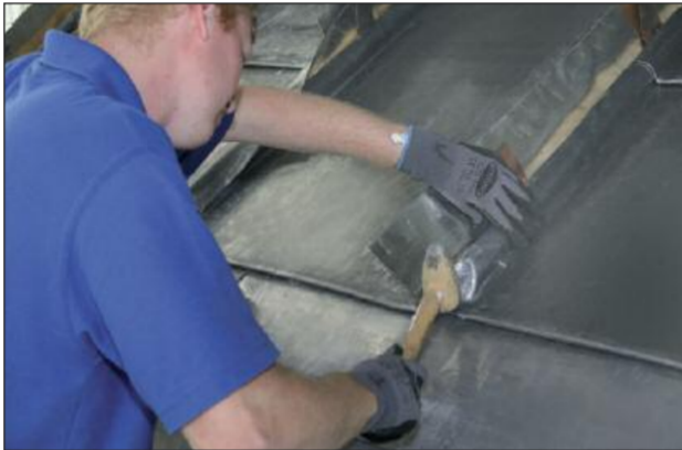
Bei großformatigen Bleiflächen zeigt die Falztechnik ihre Stärke: Die ausdehnungsfähigen Verbindungen lassen das Material arbeiten und gewährleisten stabile, sauber gegliederte Dachflächen über viele Jahre.
